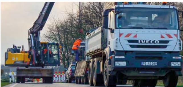
Die Tiefbau-Spezialisten im Einsatz.
