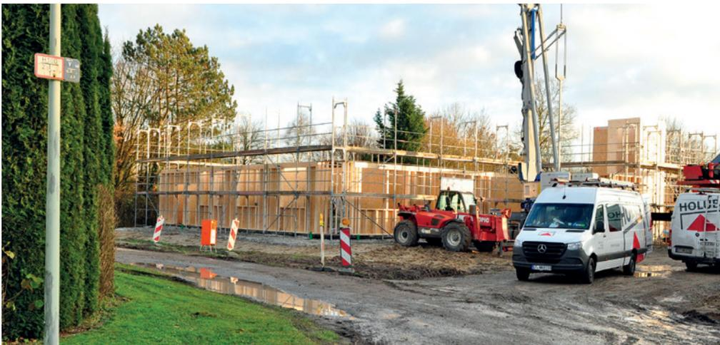
Aufwendige Baumaßnahmen einer Facharzt-Immobilie der Familie Holub haben vor einigen Tagen am Rünenbrink in Rietberg begonnen. Die bewährte Holzrahmenbau-Konstruktion ermöglicht eine extrem kurze Bauzeit.
