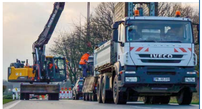
Die Tiefbau-Spezialisten im Einsatz. Foto: Bökmann Tiefbau
