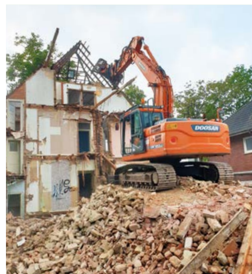
Abbrucharbeiten kleiner Gebäude bis zu Mehrfamilienhäusern, Erdarbeiten, Schüttgut-Transporte, Containerdienste im Frenser Full-Service.
