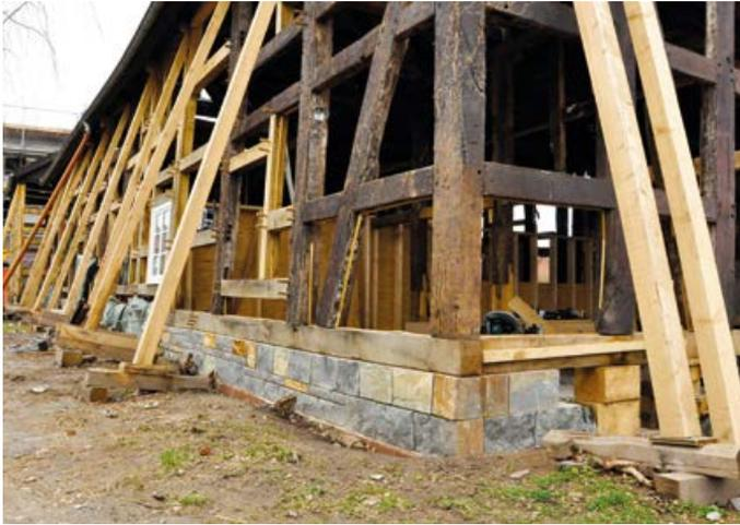
Präzise Arbeit: Die gesamte Fachwerk-Konstruktion wurde teilweise bis zu 70 cm angehoben und waagrecht auf Naturstein-Fundament gesetzt.
