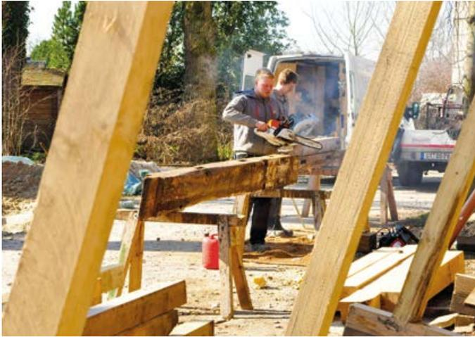
Handwerkliches Geschick war Voraussetzung für den passgenauen Zugschnitt massiver Eichenbalken die im Fachwerk ausgewechselt wurden.
