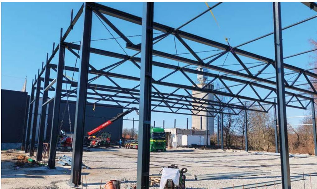
Die Stahlstützen für die neue Halle stehen bereits. Etwa 2.000 Quadratmeter groß soll sie werden bei einer Außenhöhe von acht Metern. Genug Platz also für die Bauhoffahrzeuge.
