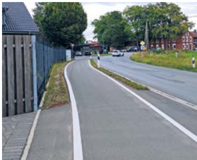
In zwei Abschnitten wurde der Bürgerradweg in Westerwiehe nun bis zur Kreuzung Kriener gebaut. Foto: RSA/Addicks
