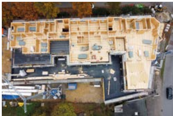
Die interessante Draufsicht in der Bauphase lässt die Raumstruktur der AWO-Kita am Jordanweg erkennen. Foto: privat
