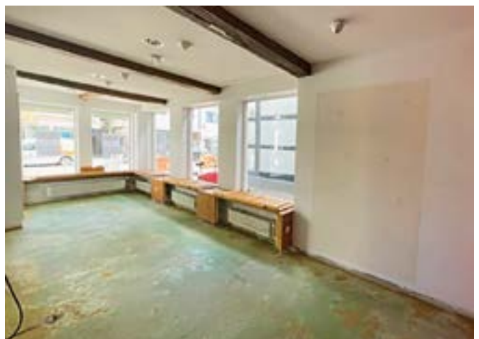
Nachdem der Innenraum komplett ausgeräumt wurde, ging es an die Renovierung mit neuem Boden und neuer Beleuchtung.
