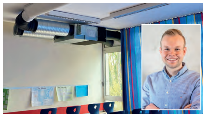
Max Gläßer hat den Einbau der Lüftungsanlagen in den Klassenräumen der Marienschule begleitet. Fotos: privat
