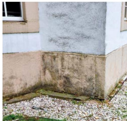
*Das Dach ist provisorisch dicht, doch Nässe kriecht zusätzlich durch defekte, bröckelnde Fundamente ins gesamte Mauerwerk.*
