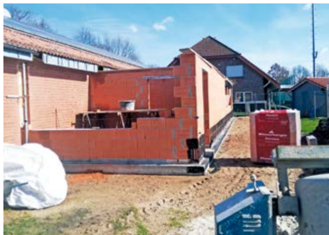
Das Vereinsheim der Schützen an der Berkenheide wird zurzeit um einen 100 Quadratmeter großen Anbau ergänzt. Die Arbeiten liegen im Zeitplan. Der Rohbau steht bereits. Foto: privat
