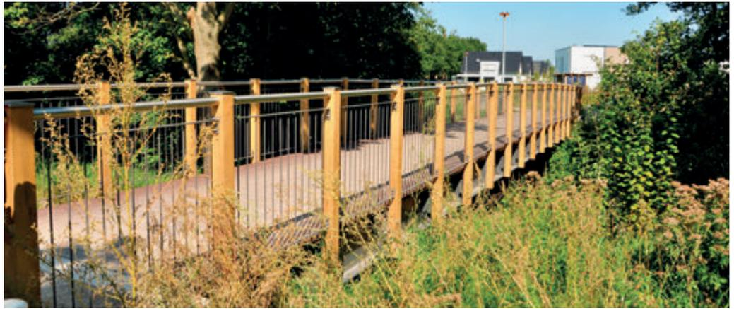
*Massiv und dennoch filigran überspannt die neue Fußgängerbrücke Rietbergs bekannten Wasserlauf. Zwei wichtige Stahlträger liefern Stabilität und Tragkraft von mehreren Tonnen Gewicht. Holzplanken bilden den Boden. Mit ca. 24 Metern Länge und drei Metern Breite wirkt sie, kombiniert mit optisch offener Geländer-Konstruktion, Massivholzpfosten und Edelstahlgitter, dezent im natürlichen Ufergrün der Ems. Foto: RSA/Rehling*
