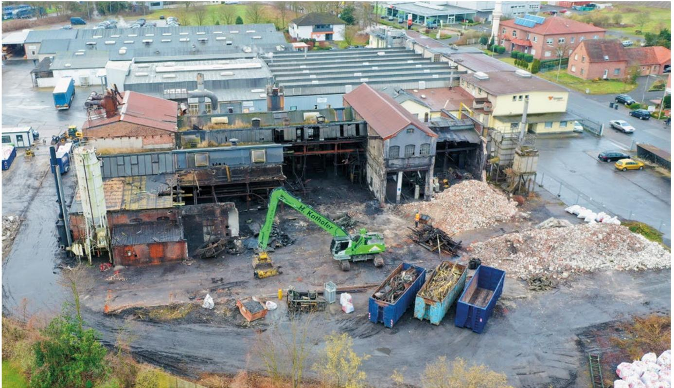
Mit einem 50 Tonnen mächtigen Longfrontbagger und weiteren Abrissgeräten wird Kempers 120 Jahre alte Eisengießerei sorgfältig zurückgebaut. Von Anfang Dezember 21 bis Ende April 22 dauern die Arbeiten an der Langen Straße 8 – 10 in Neuenkirchen auf dem 8.300 qm großen Gelände der Firma WP Kemper GmbH an. Pläne für eine weitere Verwendung der entstehenden Freifläche liegen noch nicht vor. Foto: vtp-medien Friedel Pauleickhoff
