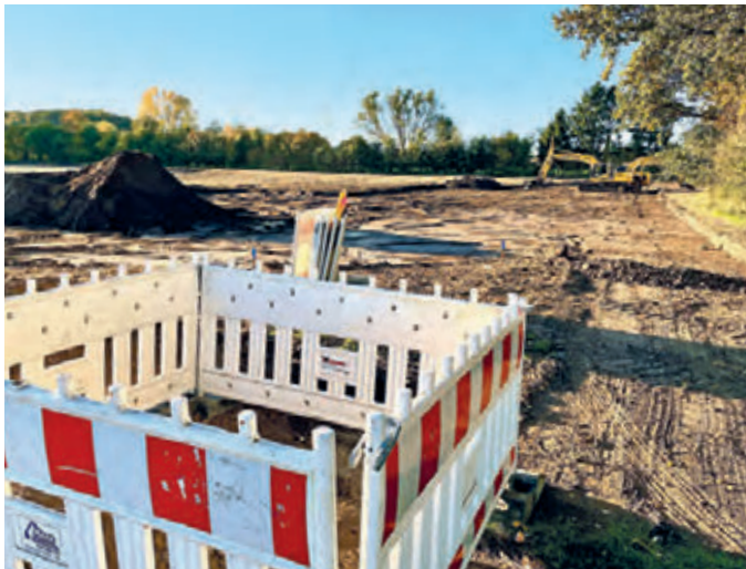
Die ersten Bodenbewegungen an der Straße Im Busche deuten bereits auf das dort entstehende Regenrückhaltebecken hin. Foto: Stadt Rietberg
