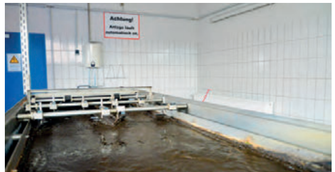
Der ausgefaulte Klärschlamm verlässt den Faulturm und wird getrocknet, um das Volumen zu reduzieren.
