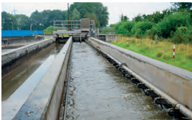
Wenn das Wasser das Vorklärbecken erreicht, sind die Grobstoffe bereits herausgefiltert. Hier setzt sich dann der Rohschlamm ab.
