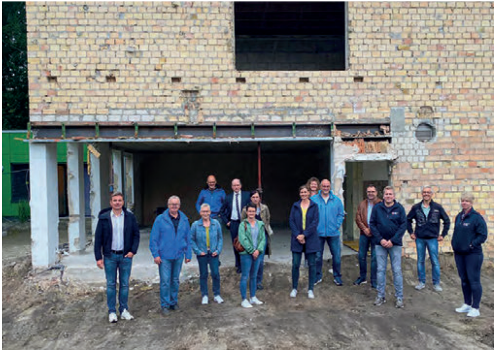
Die Bauarbeiten für die Erweiterung und Sanierung der DRK-Seniorenbegegnungstätte an der Dr. Bigalke-Straße sind gestartet. Bürgermeister Andreas Sunder (links) traf sich vor Ort mit Vertretern des Vorstandes des Roten Kreuzes.
