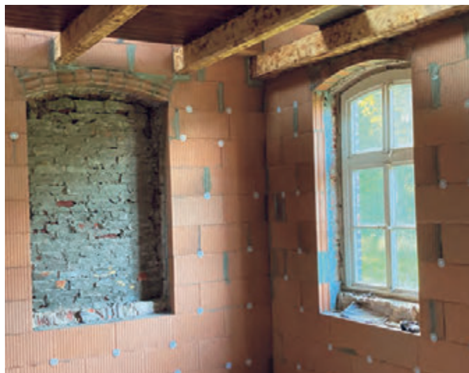
Eine Innendämmung aus Poroton bringt viele Vorteile mit sich und ist leicht zu verarbeiten. Foto: Becker Baustoffe
