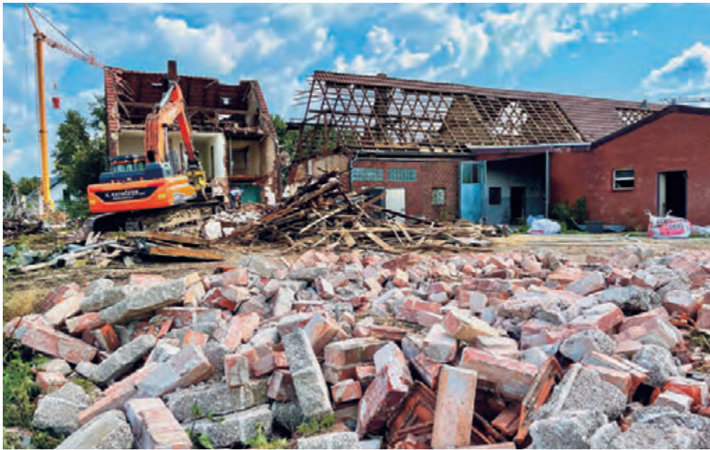
Das Grundstück muss noch erschlossen und Versorgungsleitungen sowie Schmutz- und Regenwasserkanäle verlegt werden.
