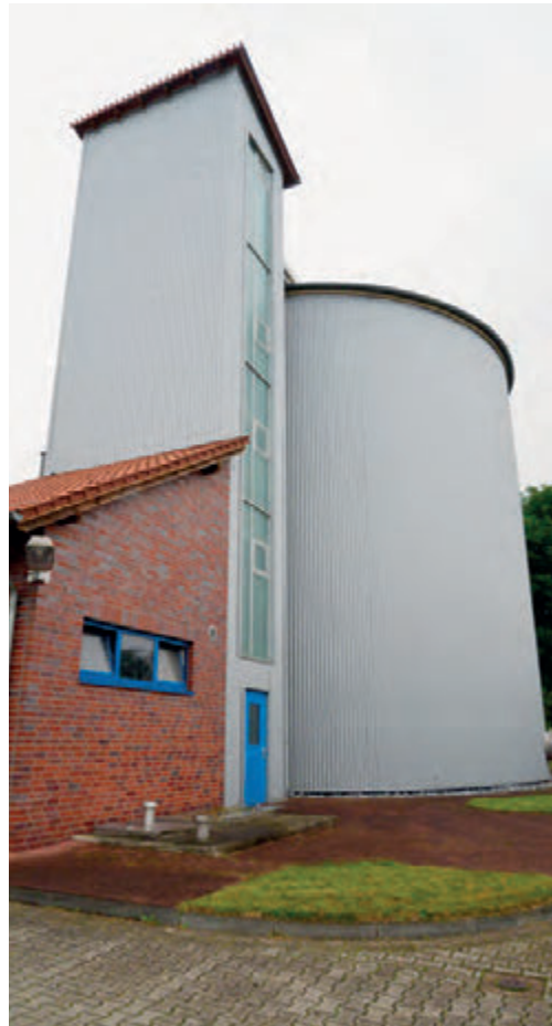
Der große Faulturm: Hier bilden sich Methangase, die anschließend energetisch verwendet werden.
