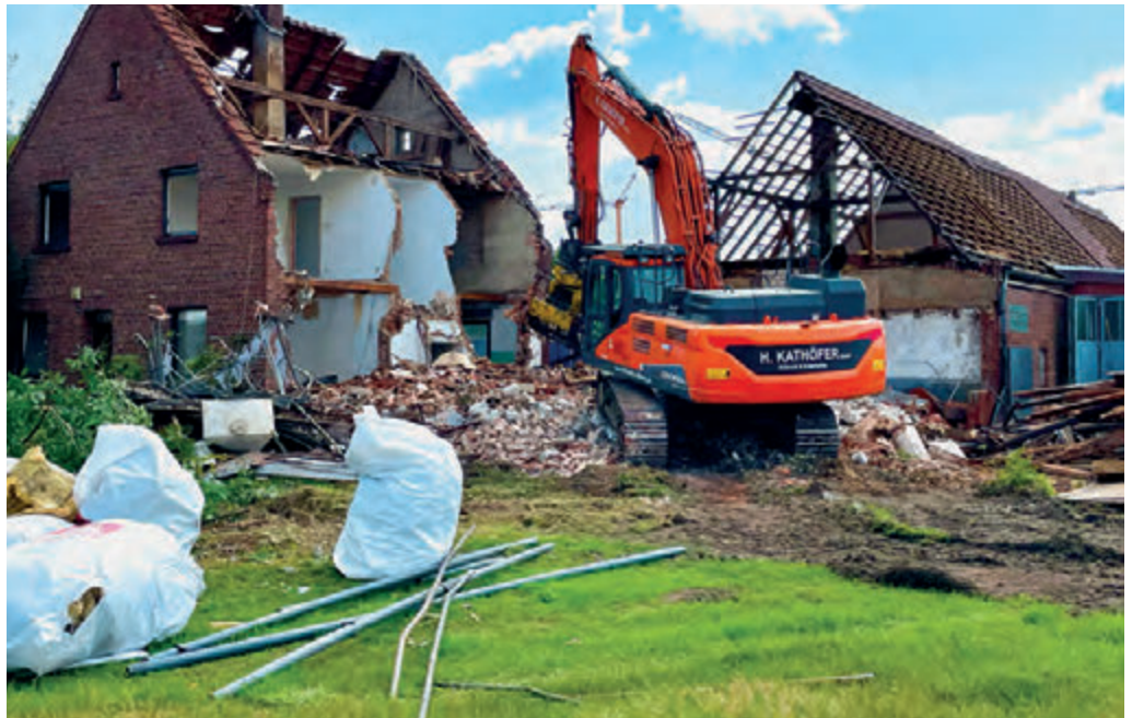
Mit Baukränen werden die Gebäude der ehemaligen Hofstelle eingerissen. Noch vor Jahresende will die Stadt die Grundstücke zum Kauf anbieten. Fotos: Stadt Rietberg
