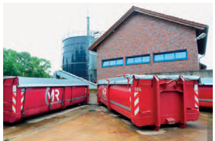
In großen Containern aufgefangen wird der Klärschlamm zu einer Verbrennungsanlage gebracht. Pro Woche sind es drei an der Zahl.
