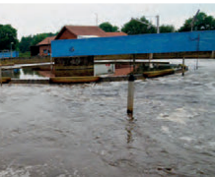
verbleibt das Wasser etwa 20 Stunden, wird gespült. Mikroorganismen reinigen das Wasser.
