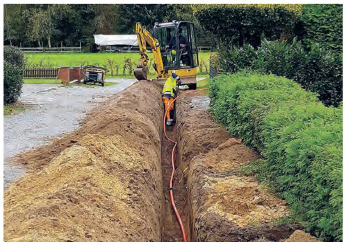
Die Mitarbeiter sorgen dafür, dass die Leerrohre für die Glasfaserleitungen schnell verlegt werden. Fotos: Helinet
