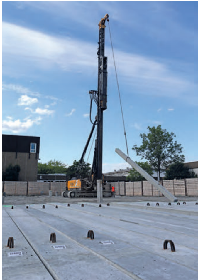
Mit einer Ramme werden die 332 Stahlbetonpfähle in den Boden befördert. Das geht nicht ohne Lärmbelästigung vonstatten. Dafür bat Andreas Sunder bei allen Anliegern um Verständnis und sprach gleichzeitig seine Entschuldigung wegen der Lärmbelästigung aus.
