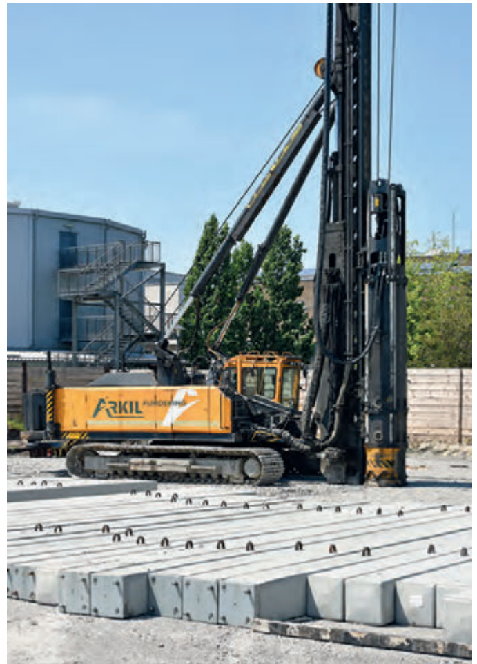
Am Torfweg entsteht für etwa 51 Millionen Euro ein neues Schulzentrum. Diese Baumaßnahme ist eine der größten und umfangreichsten in der Geschichte der Stadt Rietberg.
