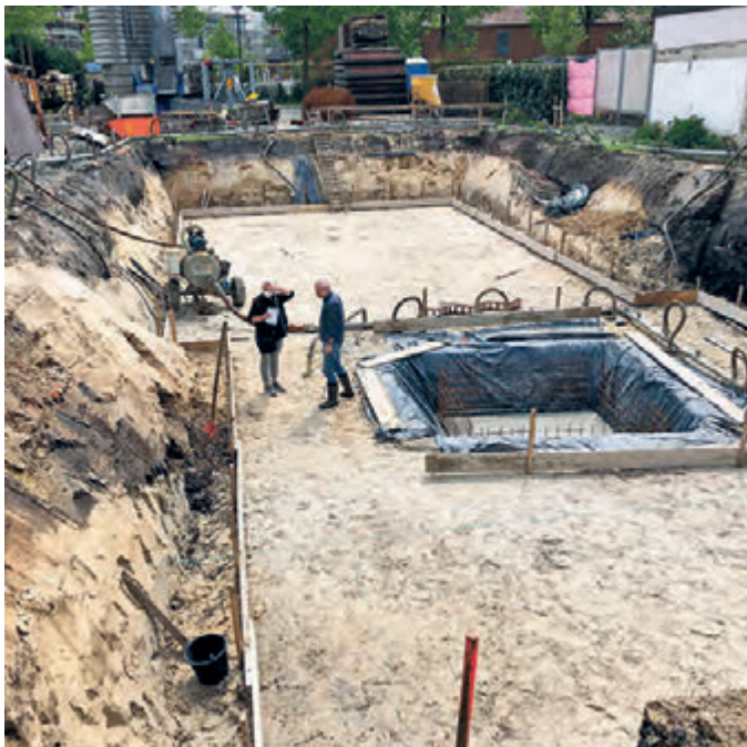
Bei Ausschachtungen für Hausneubau am Klingenham Nr. 12 wurde die Doppelgraben-Wallanlage im Erdreich entdeckt (oben rechts). Fotos: J. Glaw
