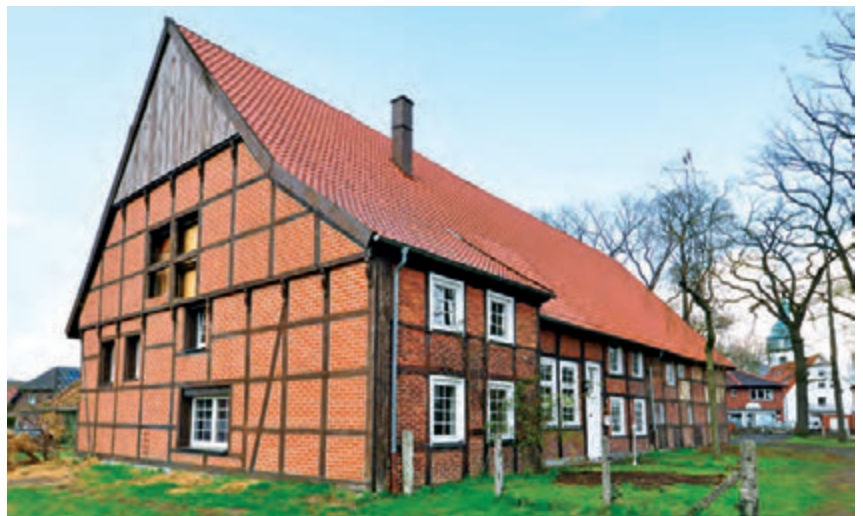
Hier an der westlichen Giebelfront, mit dem Hofhaus verbunden, entsteht ein neues Apartmenthaus mit Wohnräumen inklusive Bädern für die Bewohner von Duhmes Hof.
