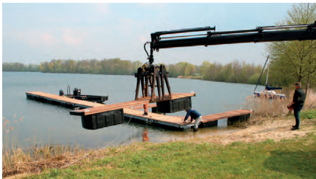
Mit Hilfe eines großen Krans werden die einzelnen Stegteile an ihren Bestimmungsort gehievt und zusammengebaut. Darauf hatten sich die Mastholter Wassersportler lange gefreut.
