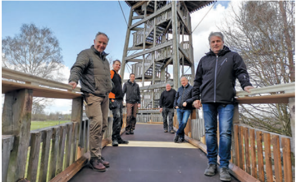
Begutachten zum Ende der Arbeiten die neue Rampe am Aussichtsturm: Rainer Honerlage (v.l.), seine Mitarbeiter Jan Schlaumann und Patrick Rehkemper, Parkmeister Helmut Kammermann, Gartenschaupark-Geschäftsführer Peter Milsch und Dirk Ehlers (Förderverein des Gartenschauparks). Foto: privat
