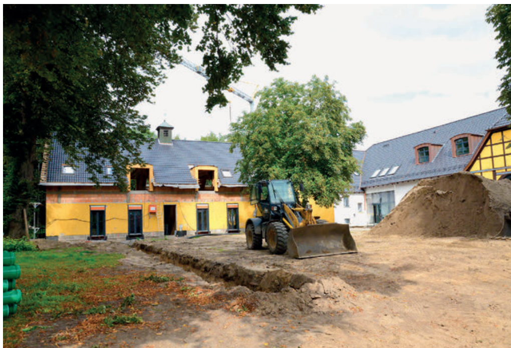
Es sieht schwer nach Arbeit aus auf dem Gut Rietberg. In dem ehemaligen Stutenstall (links) und dem Abfohlstall (rechts) entstehen neue Wohnungen. Fotos: RSA/Addicks
