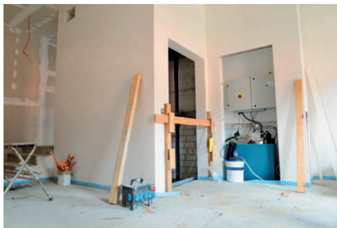
Der Fahrstuhl ist bereits eingebaut und sorgt dafür, dass die künftigen Bewohner barrierefrei in ihre Wohnungen gelangen können.
