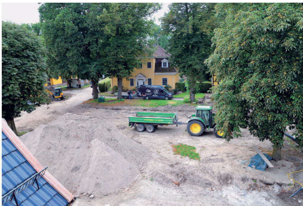
Derzeit noch eine Baustelle. Aber schon im kommenden Jahr soll der Innenhof des Gutes Rietberg die Bewohner der umliegenden Gebäude zum Verweilen einladen.
