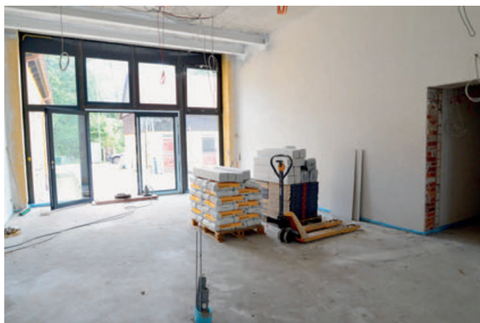
Die geschlossene Durchfahrt kann bald als lichtdurchfluteter Speise- und Aufenthaltsraum dienen.
