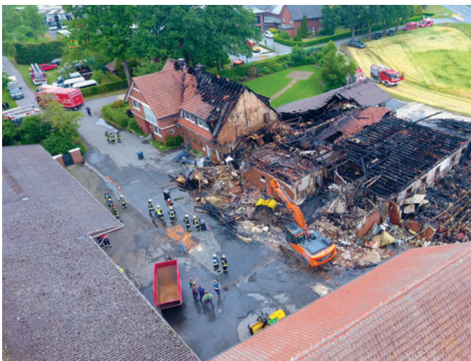
Beim verheerenden Großbrand auf dem Hof Kirschstein wurden Stallungen und Wohnhaus ein Raub der Flammen. Ein Neuaufbau ist geplant. Foto: Kreisfeuerwehr-Verband GT
