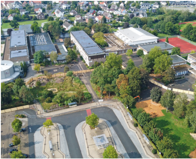
Der große Zaun grenzt das zu bebauende Areal ab. Hier soll bald der Neubau des Gymnasiums entstehen. Foto: RSA/Steinberg
