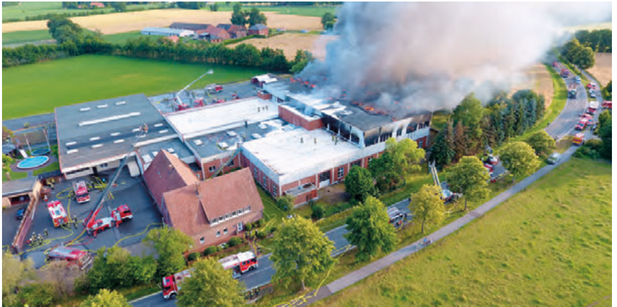
Ein Blick von oben lokalisiert das Brandgeschehen. Während ein Übergreifen der Flammen auf andere Betriebshallen durch den massiven Einsatz der Feuerwehren verhindert werden konnte, scheint es für die Produktionshalle keine Rettung mehr zu geben.
