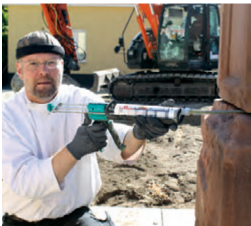
Bildhauer Hans-Bernhard Vielstädte setzt die Druckpunkte für die bessere Stabilität des Bauwerkes.
