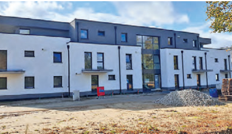
Im Erdgeschoss links wird die Demenzgruppe einziehen, der Pflegedienst 2000 bezieht die Räume auf der rechten Seite.
