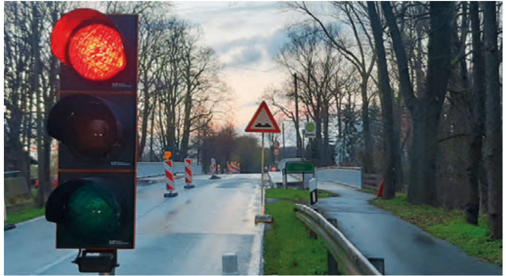
Die Fahrbahn auf der Brücke wird sowohl auf der Straße als auch auf dem Radweg saniert. Foto: RSA/Addicks
