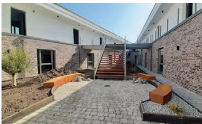
Mediterraner Charme im Innenhof: Eine breite Treppe führt zu den Räumen in der oberen Etage. Es fehlt noch die Geländerverglasung.
