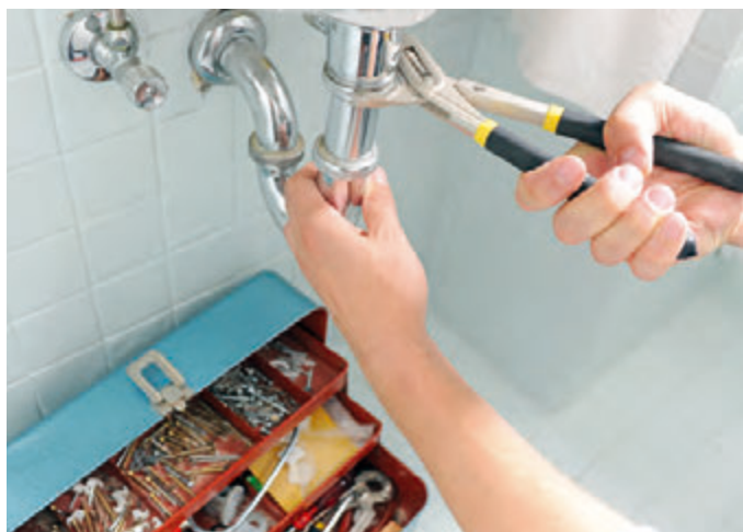
In der Ausbildung werden neben den Installations- auch Reparaturfertigkeiten vermittelt.
